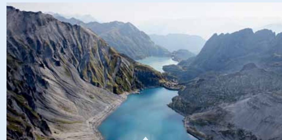
Les bassins, situés à des altitudes différentes, de la station de Nant de Drance près de Chamonix.
